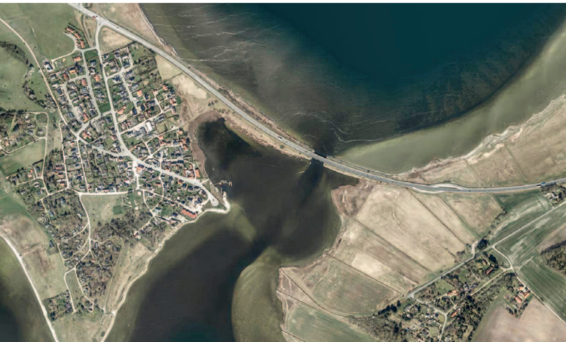
Luftfotografiet fra 2019 viser den nye bros placering nord for, hvor de første to broer havde ligget. Endnu findes aftegning fra dæmningen i vandet ud for Besser By. Vejdirektoratet ønskede den bedre vejforbindelse, hvilket forsinkede byggeriet.
