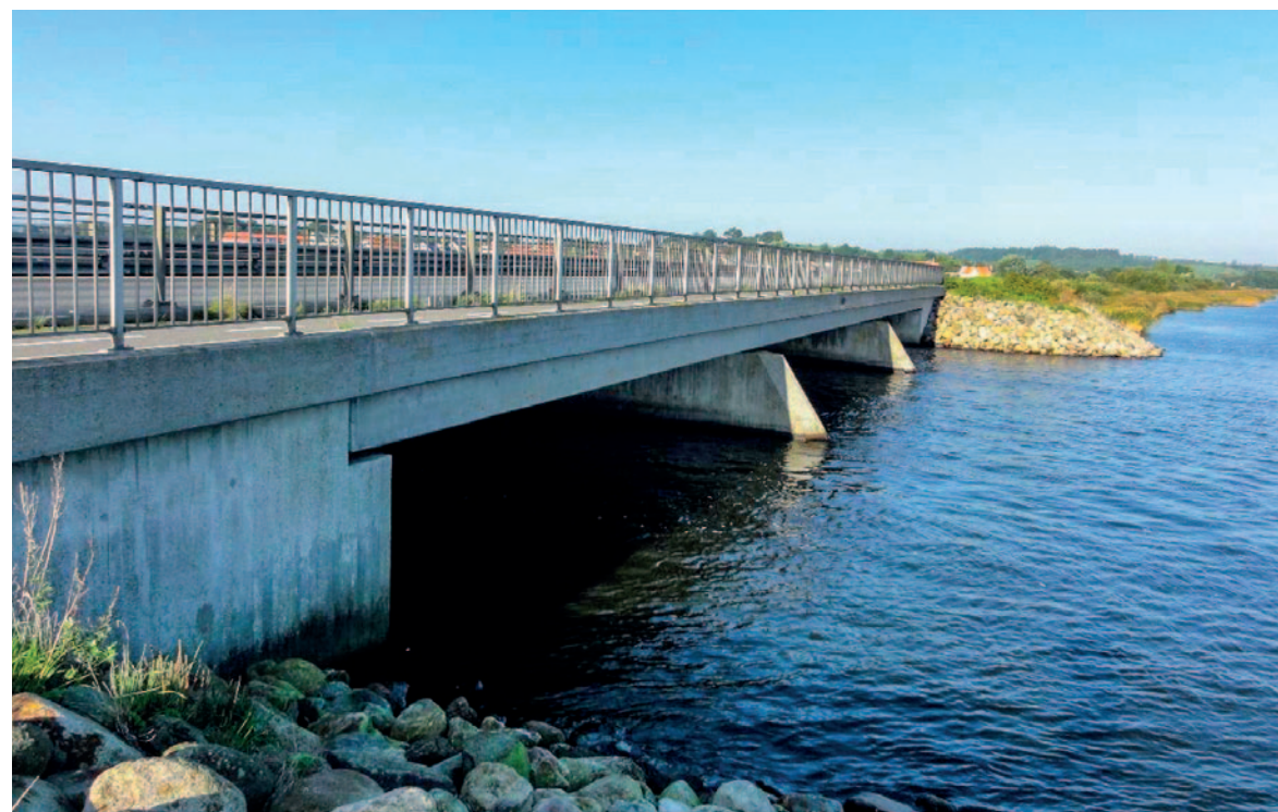
En ny bro indviedes i 1983. Den var 40 m lang, men takket være stærkere betonbjælker kunne den nøjes med at understøttes af to piller.
