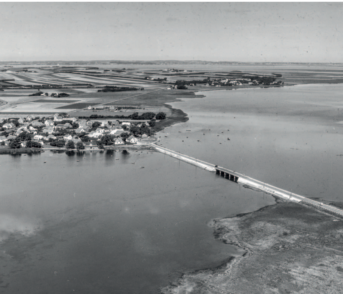
Luftfotografiet fra 1956 viser broens placering tæt på den østre bred og den lange dæmning vestpå mod Sebber.
